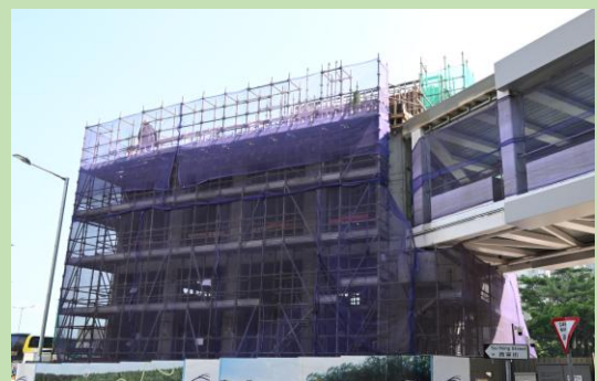
升降機塔工程 Lift Tower Construction
